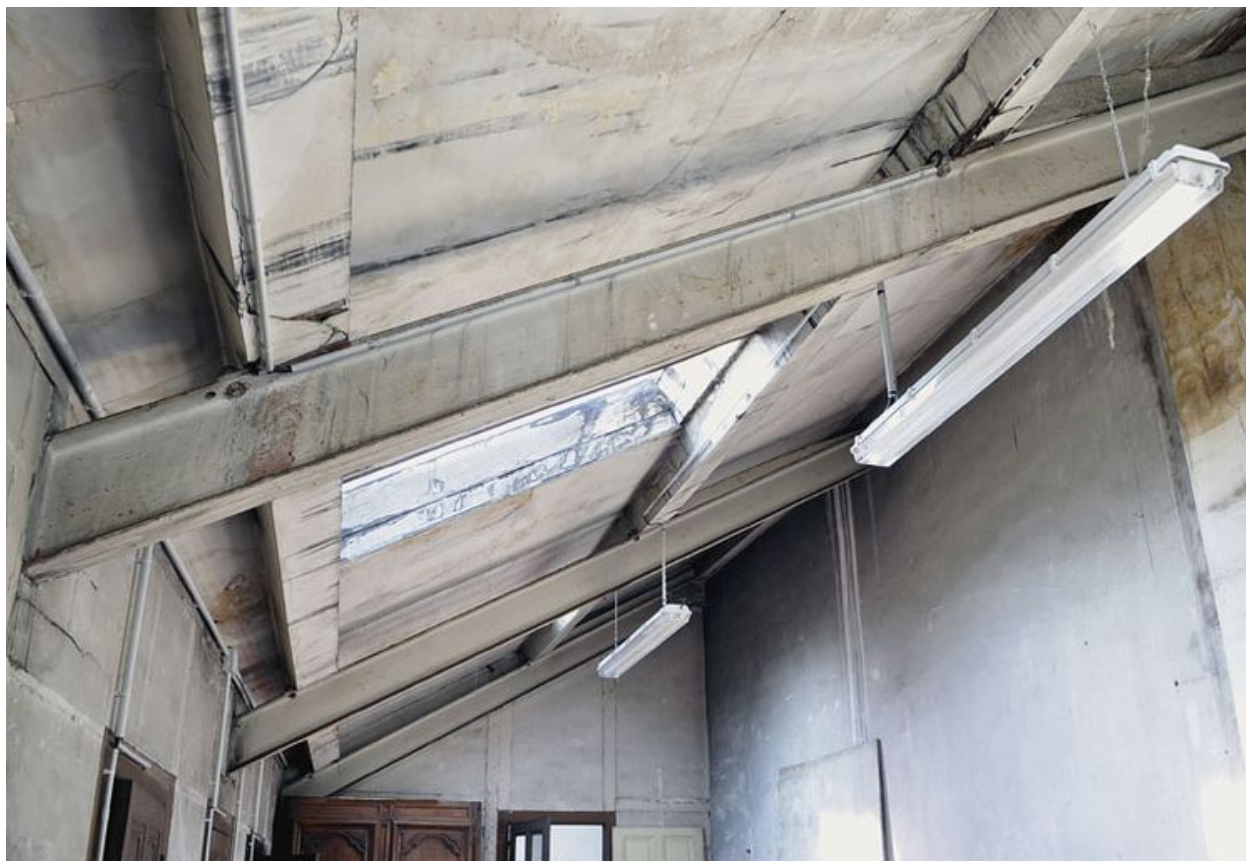
4e étage : charpente métallique.
