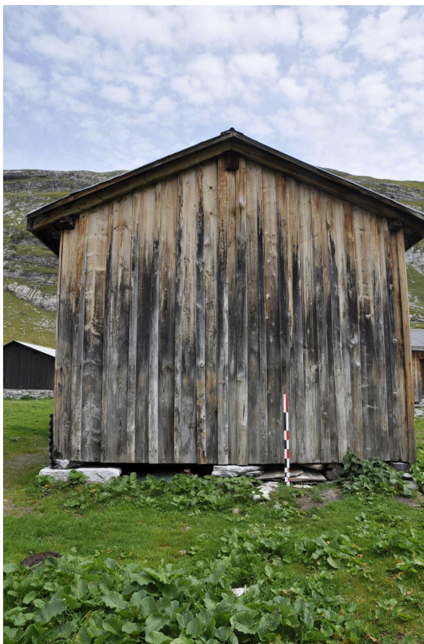
Vue du mur pignon ouest
