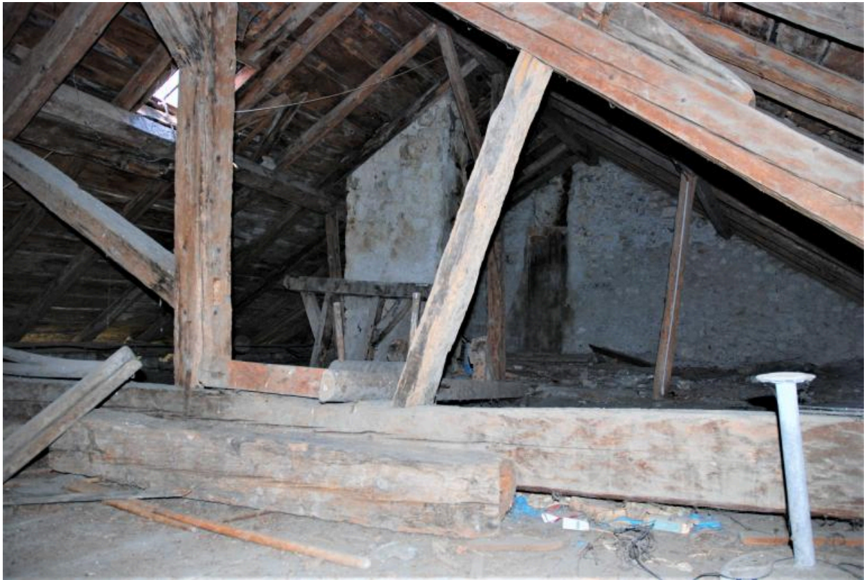
Etage de comble, vue en direction du nord. Vue d'ensemble du massif abritant les chambres du premier étage situées au nord.
