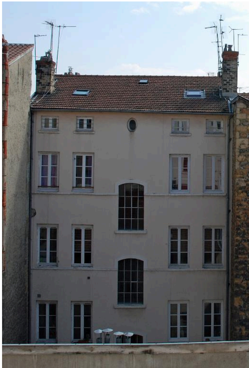
Immeuble sur rue, élévation postérieure
