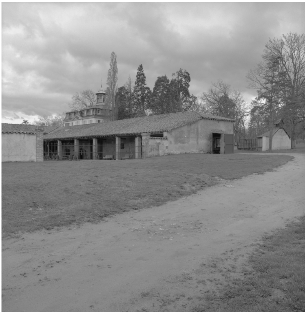
Vue du corps de bâtiment ouest, avec le chenil à droite, du nord-est.
