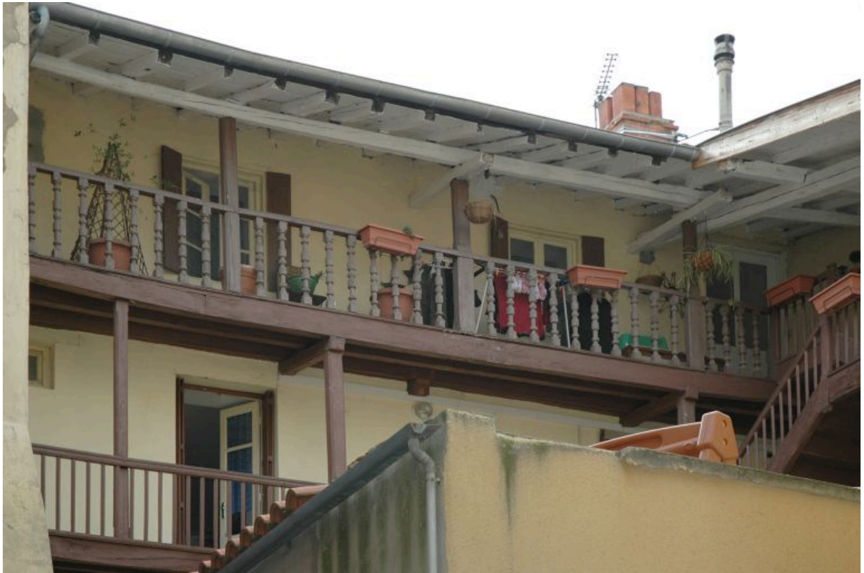
Vue de l'étage en surcroît sur cour : coursière avec garde-corps en bois tourné.
