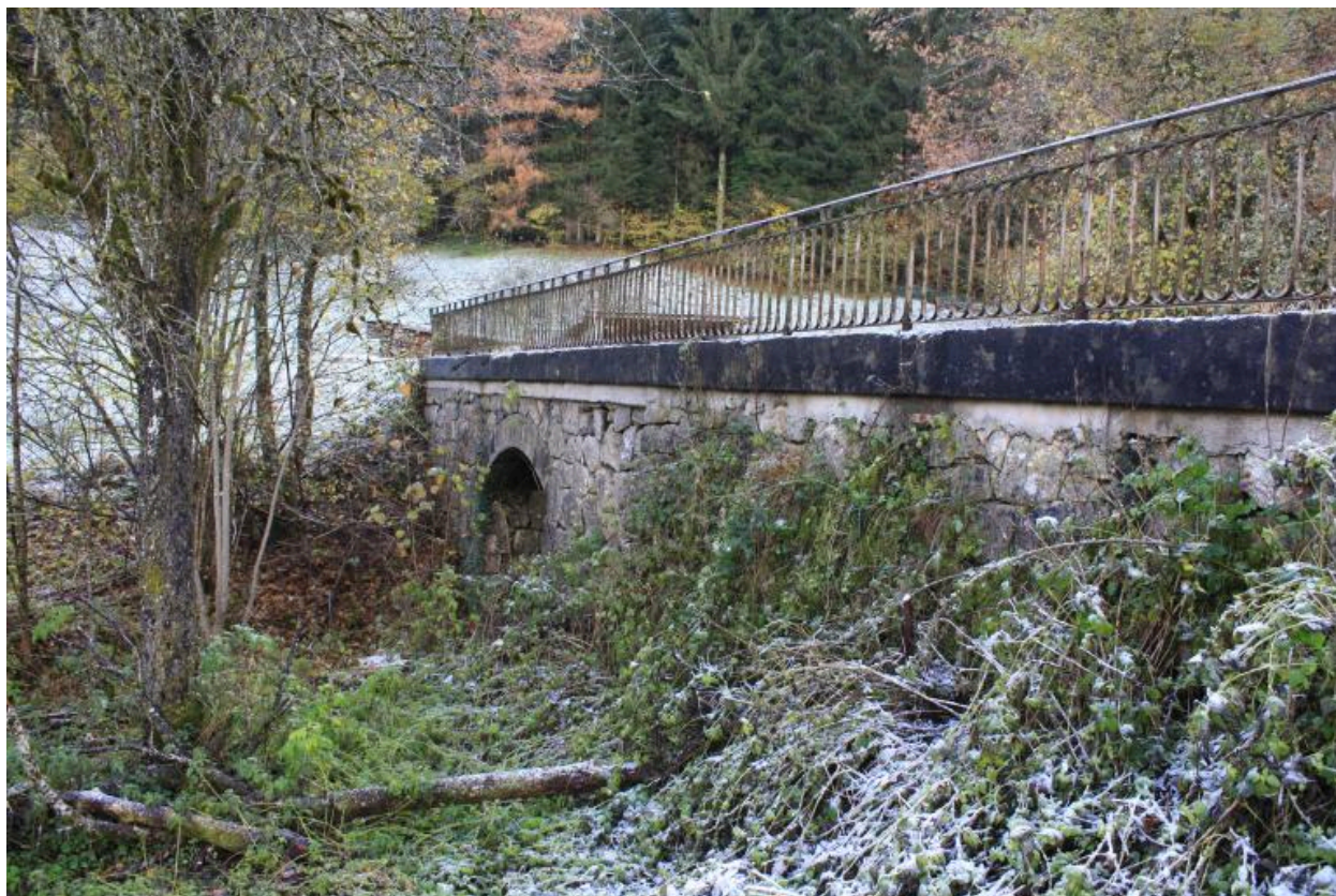
Le vieux pont de Trélachaud, face aval
