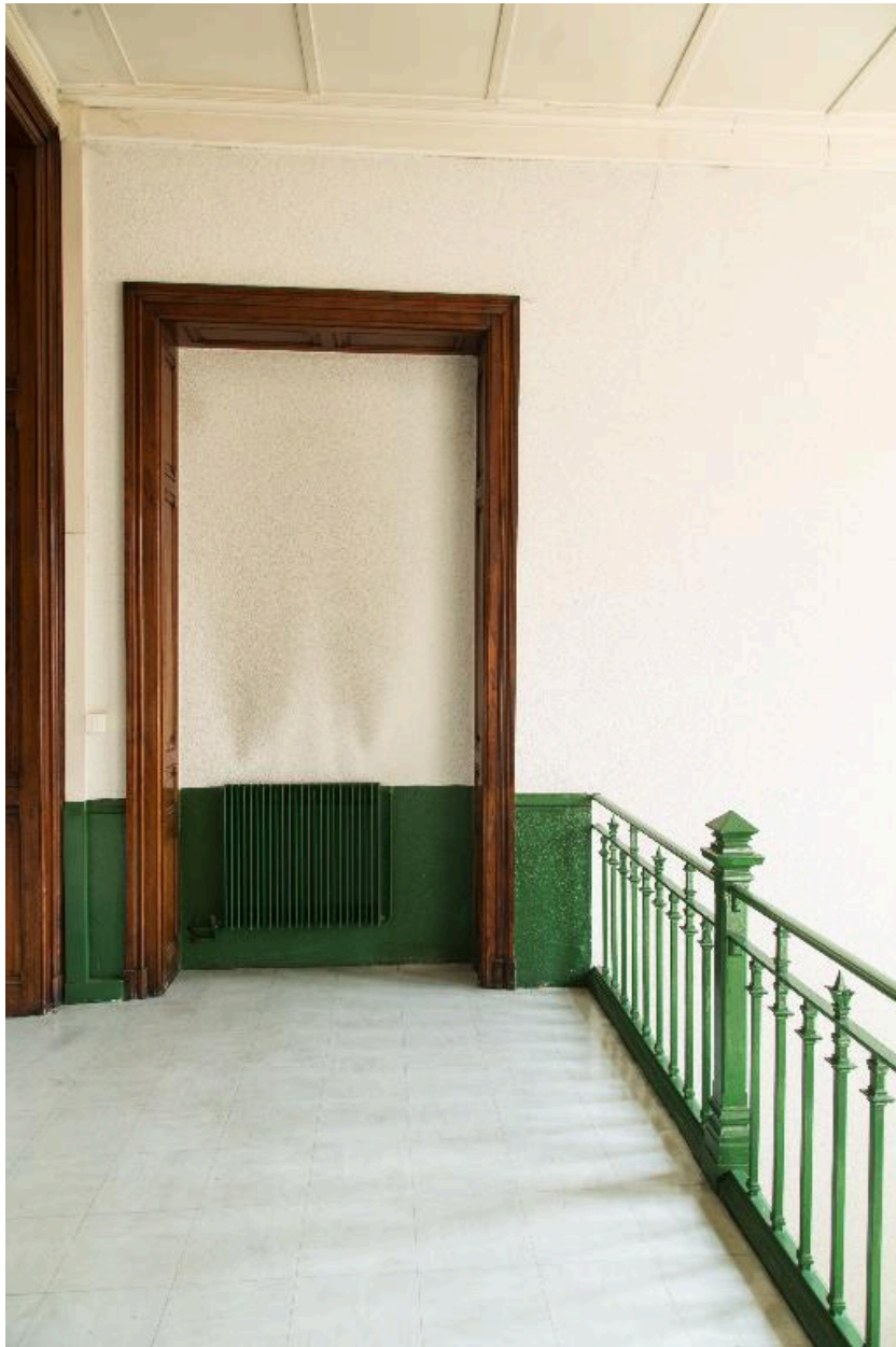
Bâtiment A, premier étage, face à la salle des conseils
