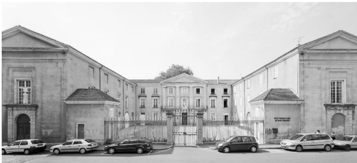
Vue de la sous-préfecture depuis le nord.
