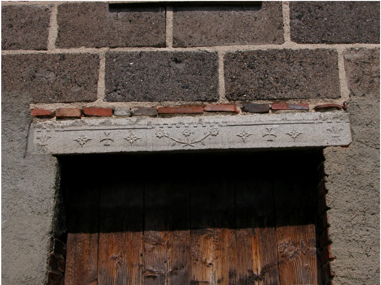
Détail du linteau du fournil : emploi d'un linteau de cheminée.
