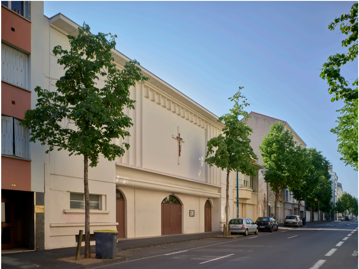
Elévation des n°17, 17bis et 19 sur l'avenue d'Italie. A l'arrière-plan, mur d'héberge du n°21
