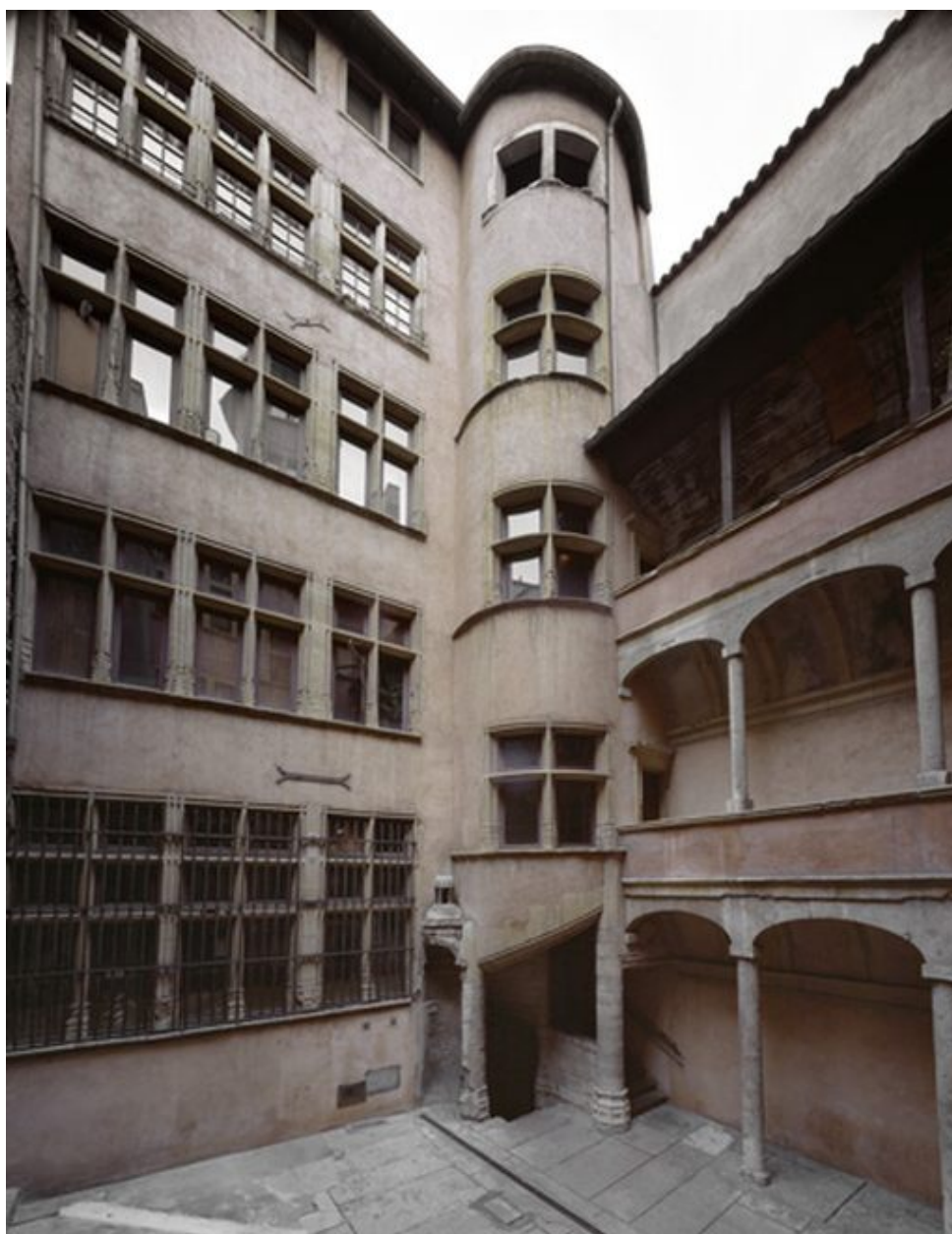
La cour : corps de bâtiment ouest, donnant sur le quai Saint-Antoine, puits, cage d'escalier et galerie de liaison
