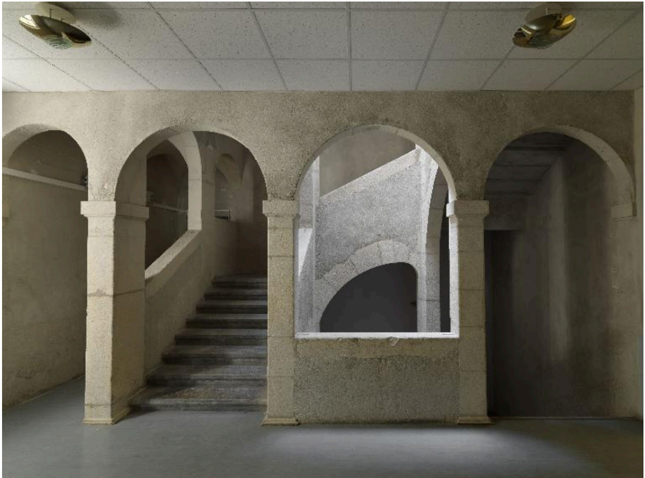
Vue du deuxième palier de l'escalier à quatre noyaux
