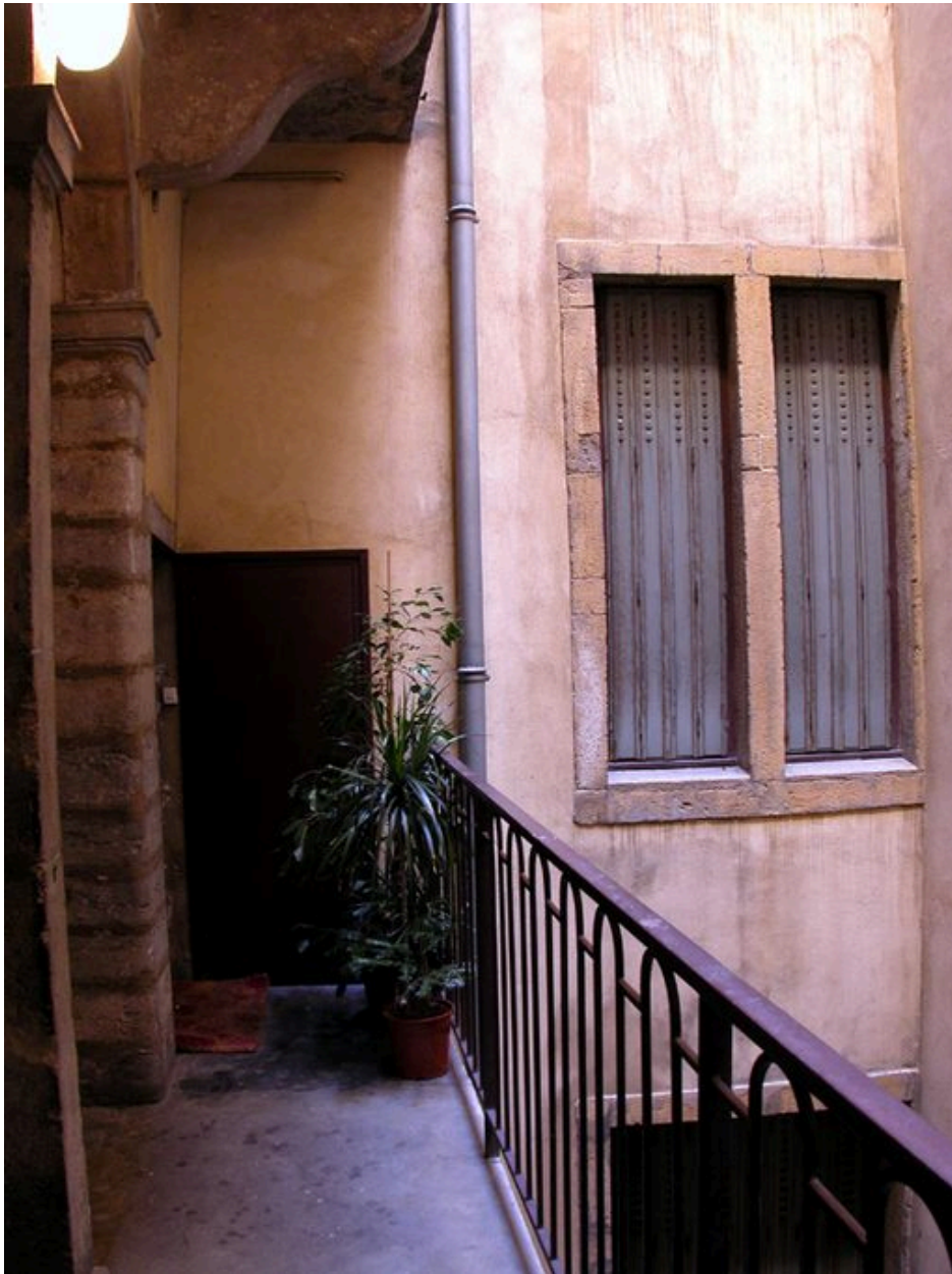
Palier et vue partielle de l'élévation est de la cour
