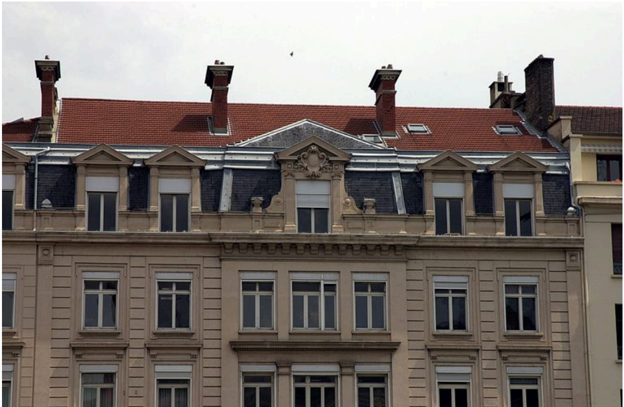
Toit du bâtiment construit en 1903
