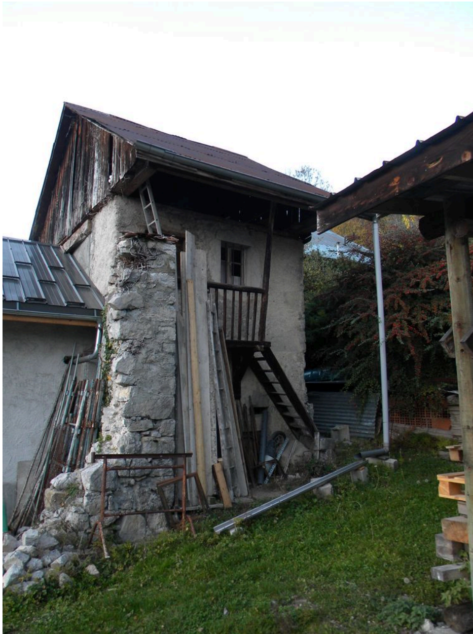
Vue d'una ancien cellier accolé à un bâtiment contemporain (2008 A8 1857)
