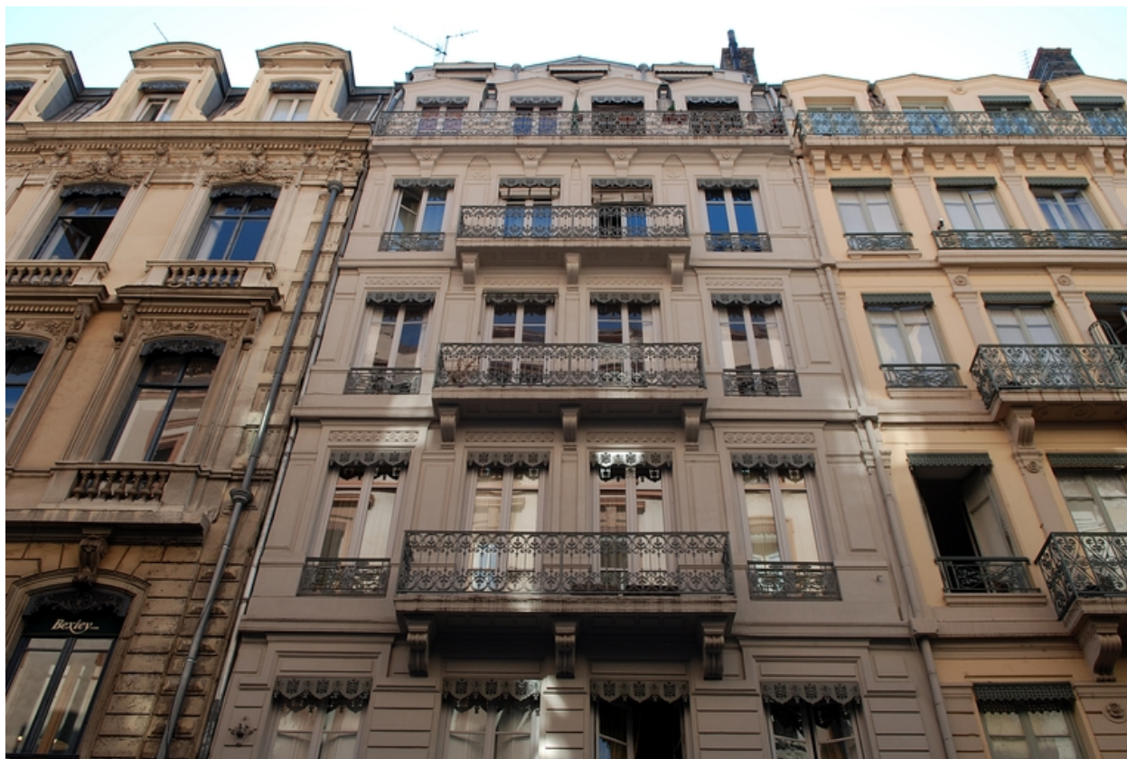
Elévation antérieure : partie supérieure
