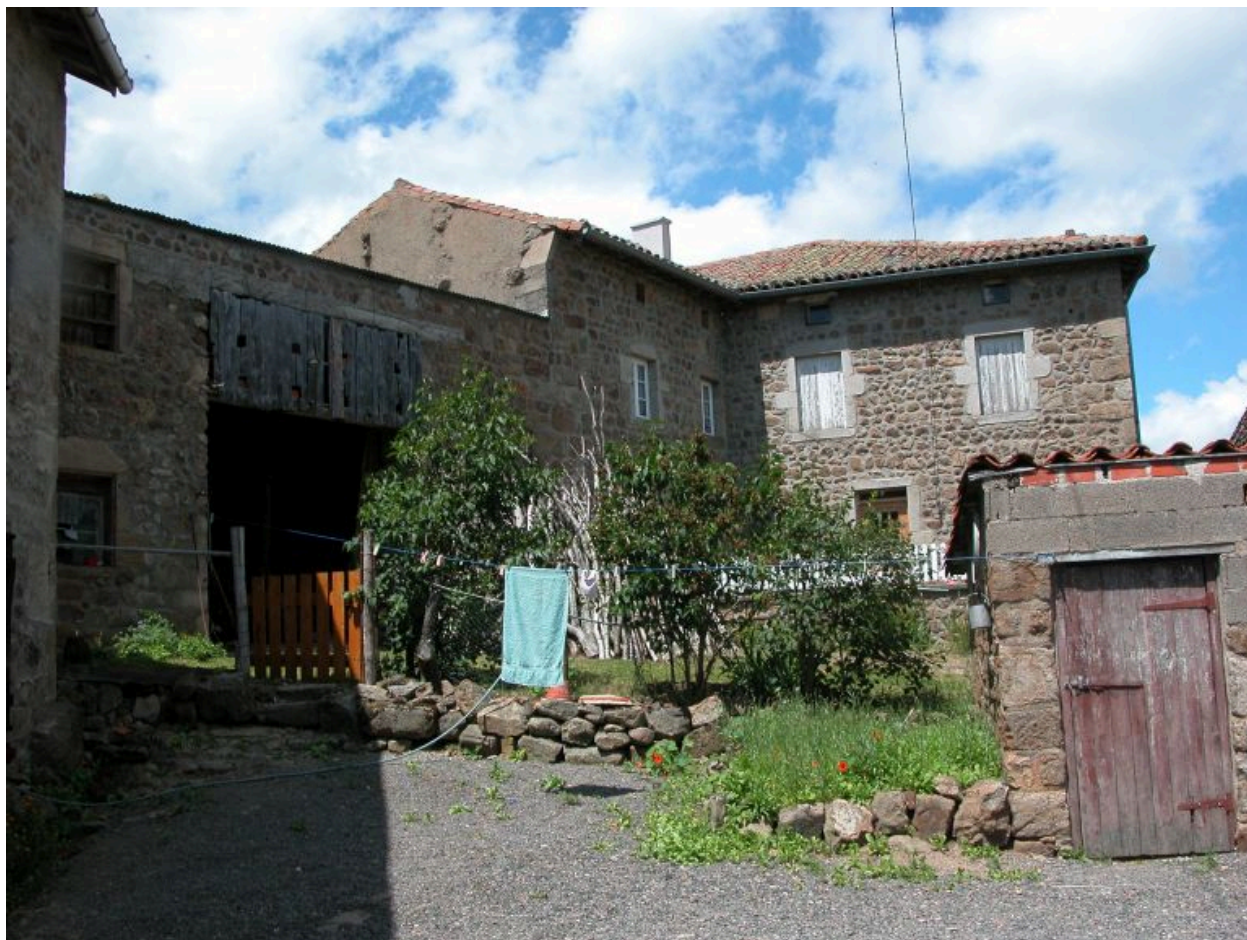
Vue générale avant de la ferme.
