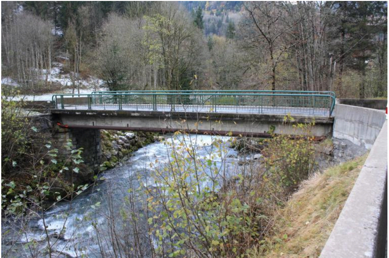
Pont de la Moussière, face amont
