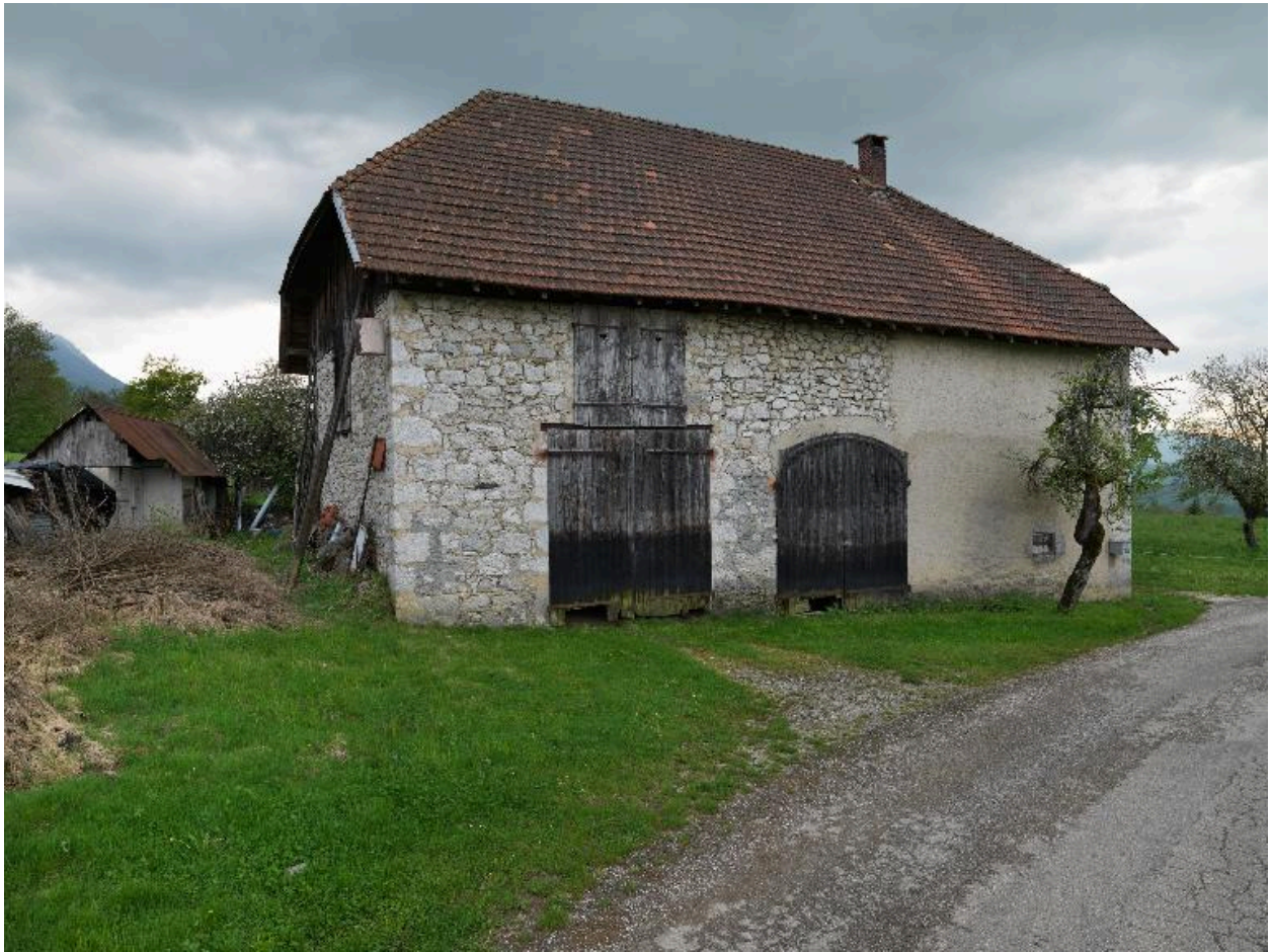
Vue d'ensemble arrière de la ferme.
