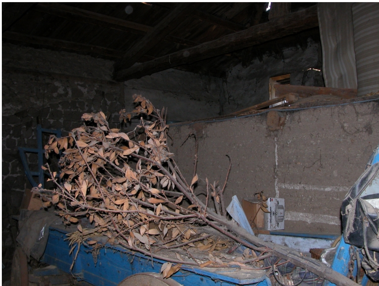
Vue intérieure de la grange.
