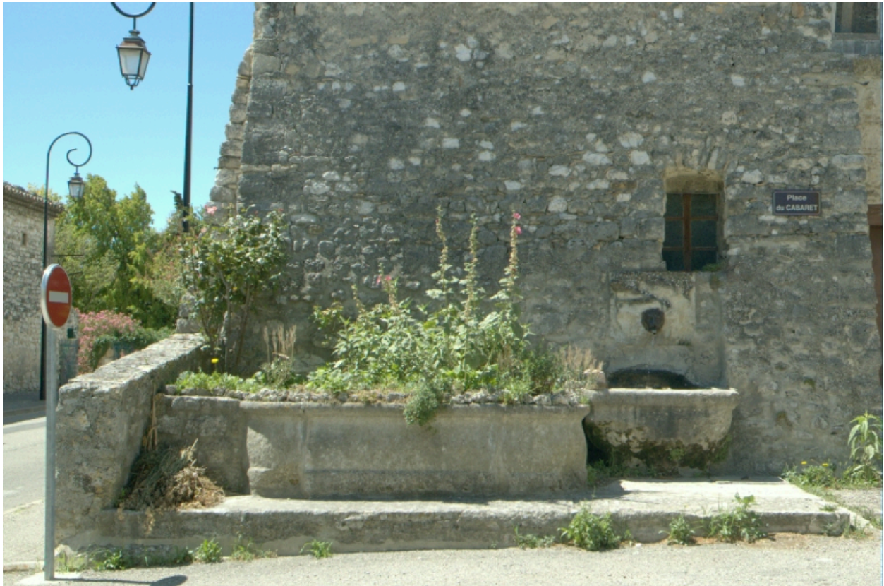
Salles-sous-Bois, place du Cabaret, fontaine et ancien lavoir.
