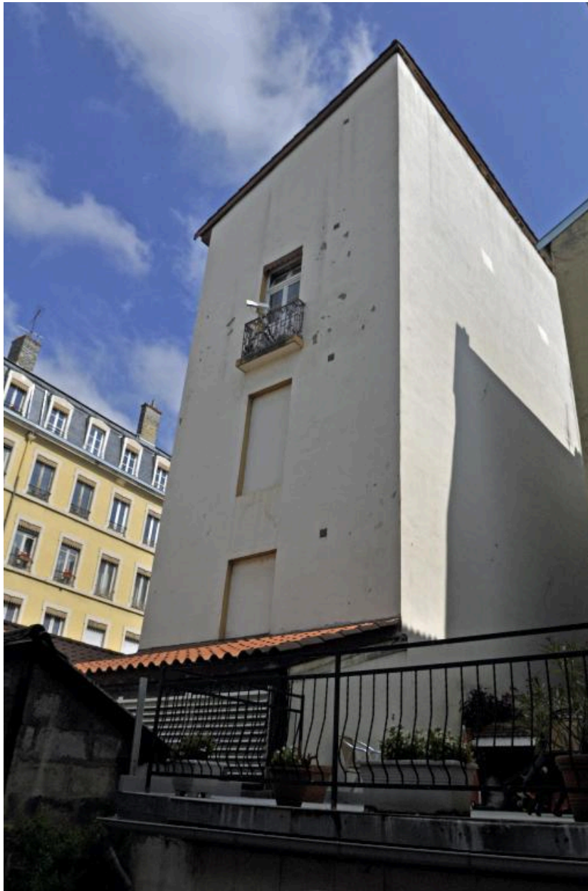
Elévations latérale et postérieure du retour du L, couvert à un pan
