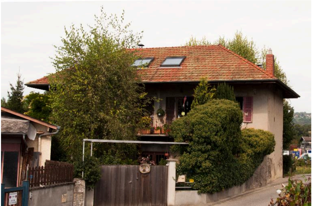
Vue générale, façade principale orientée au sud
