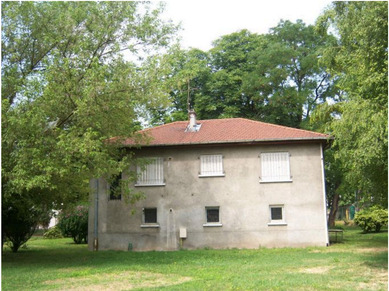
Bâtiment Nord Est, élévation Sud
