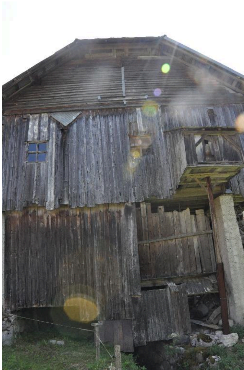
Vue du pignon ouest de la scierie.
