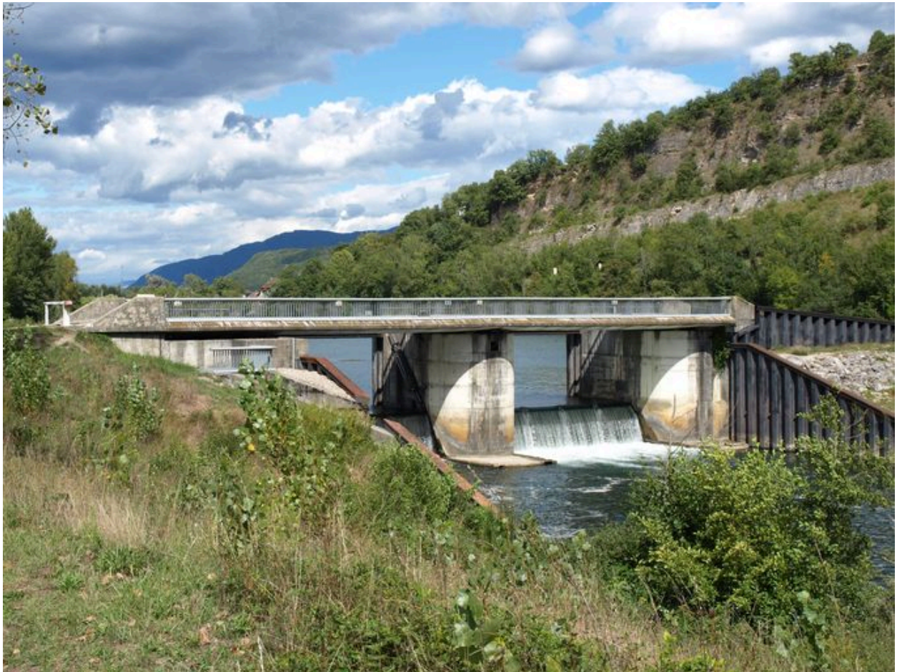
Vue générale du barrage, face aval (depuis la rive droite)
