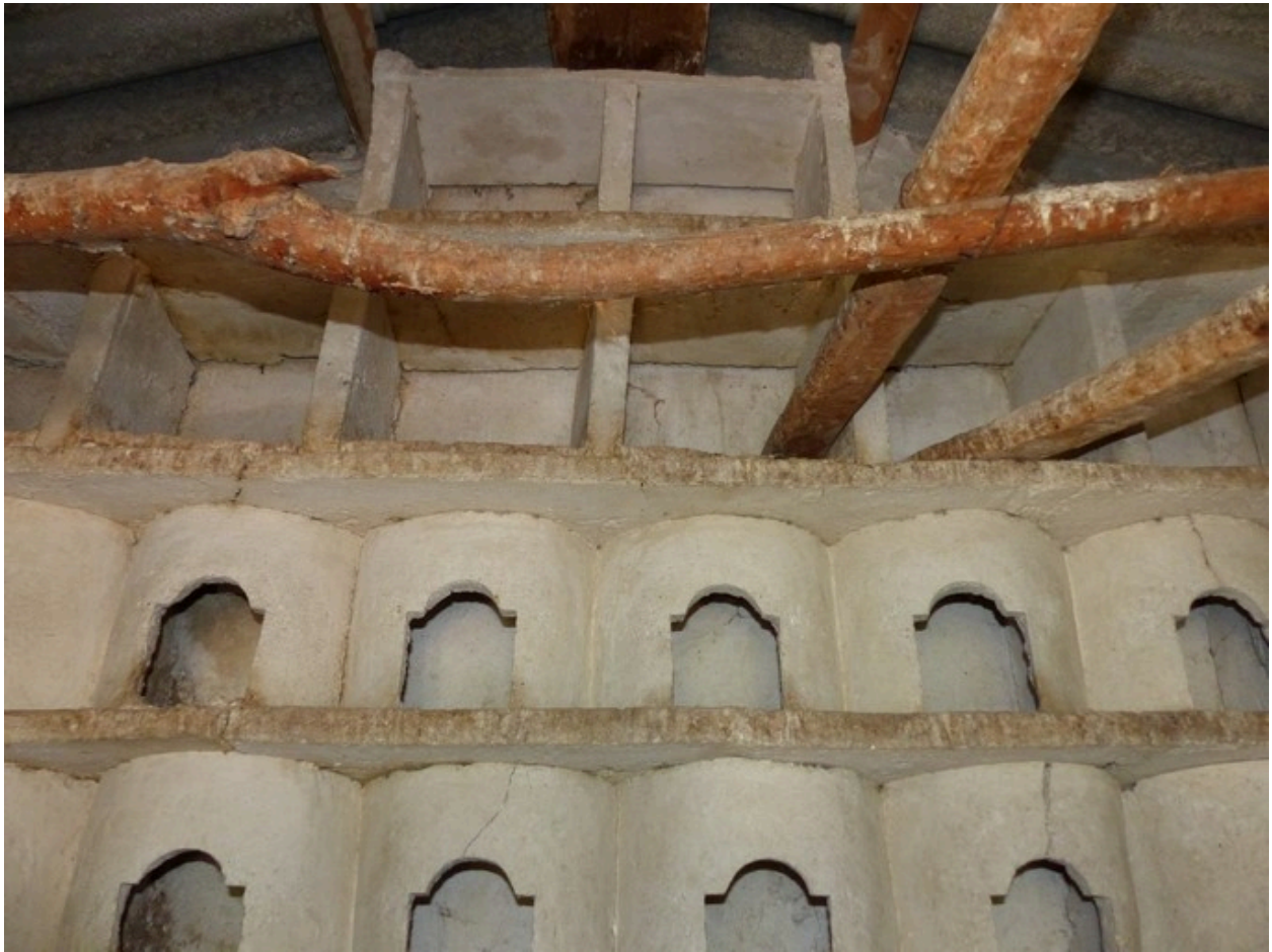
Etage de comble. Mur nord, boulins.
