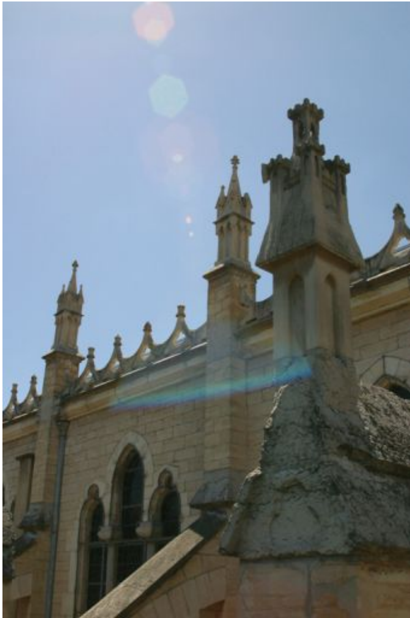
Contreforts et arcs-boutants amortis par des clochetons, premières travées nord
