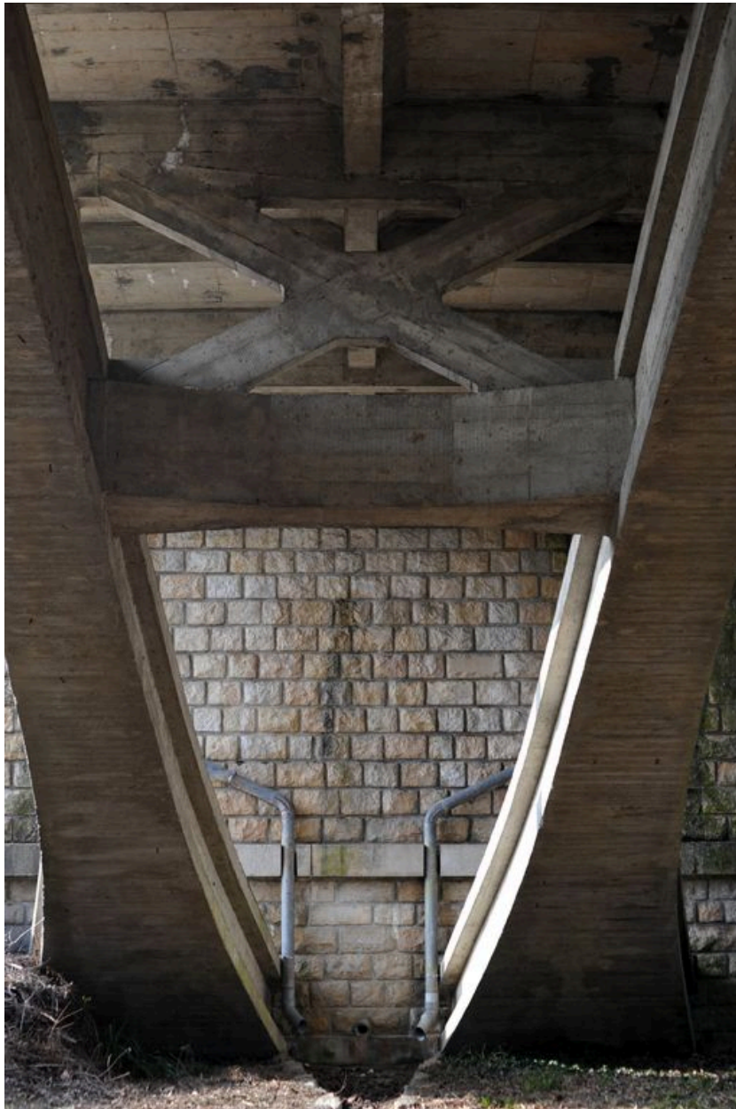
Culée droite, vue partielle : ancrage des arches (depuis la rive droite)
