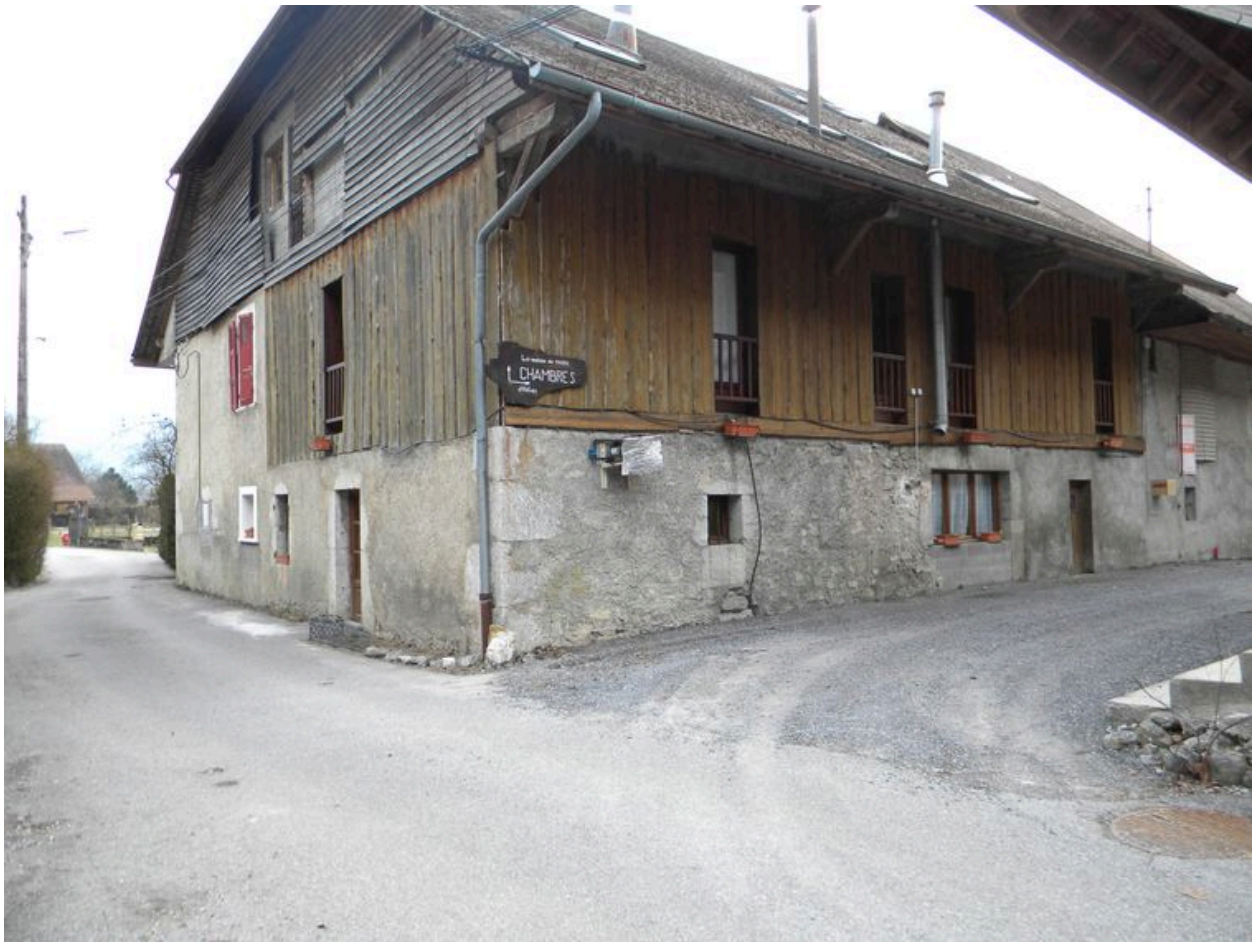
Façade nord d'une ancienne ferme à juxtaposition (2008 B2 272,273,278 et 2315).
