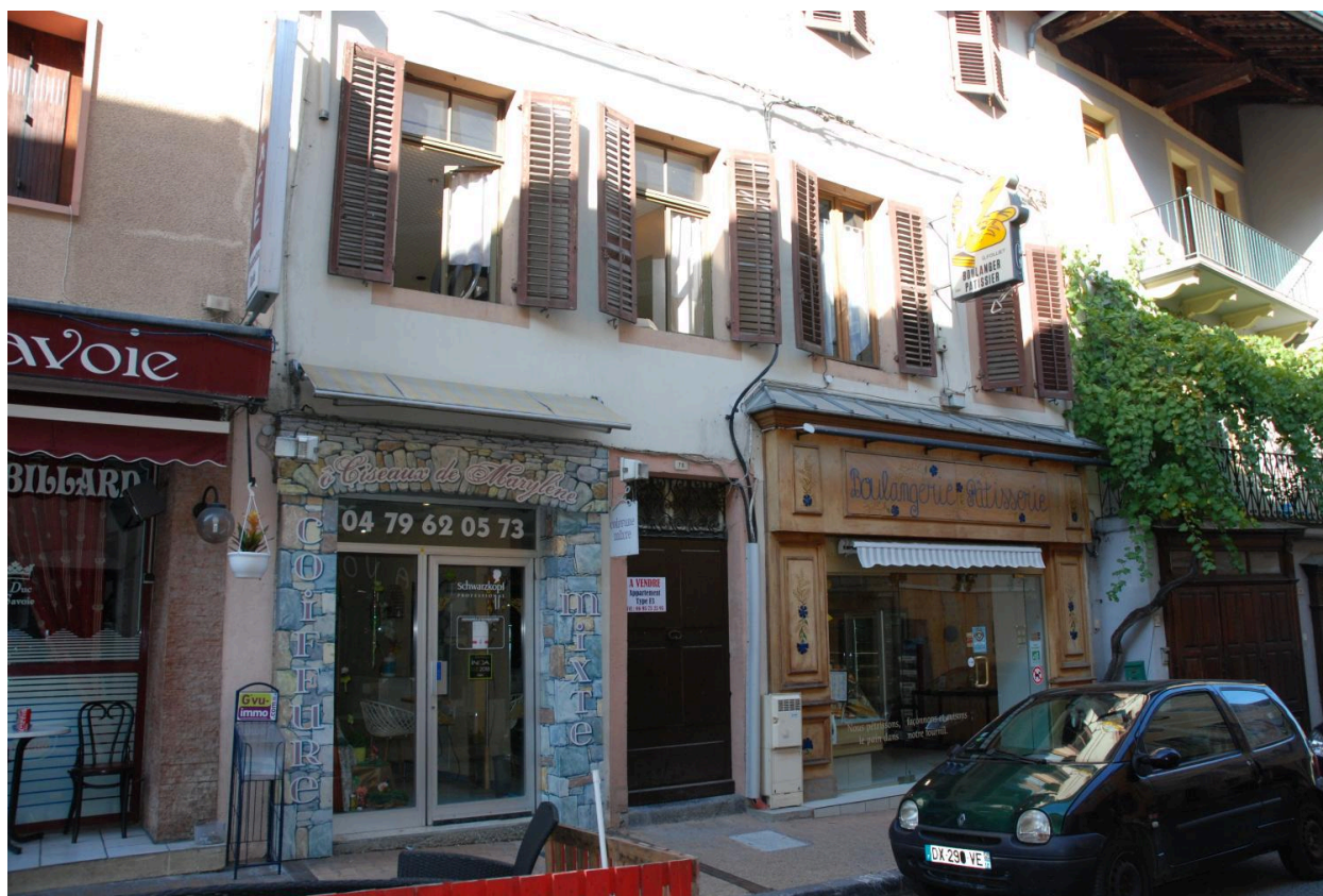
Maison, immeuble, 78 rue Louis Blanc-Pinget (2018 E1 341). Elévation sur rue.
