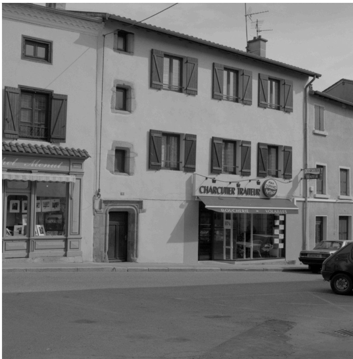
Maison, 11 place de la République. Vue générale de la façade principale, de l'ouest.
