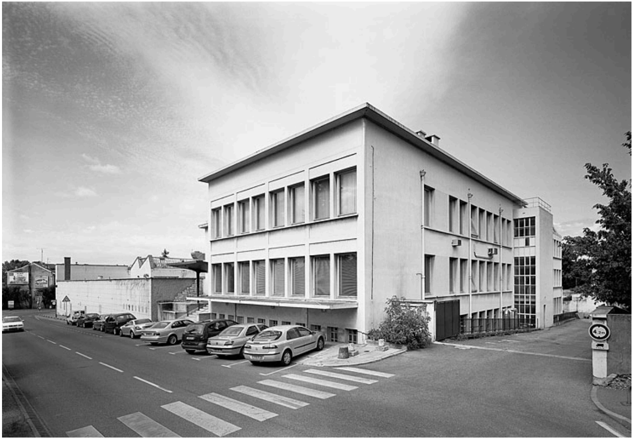
Bâtiment administratif et entrée fournisseurs et livraison
