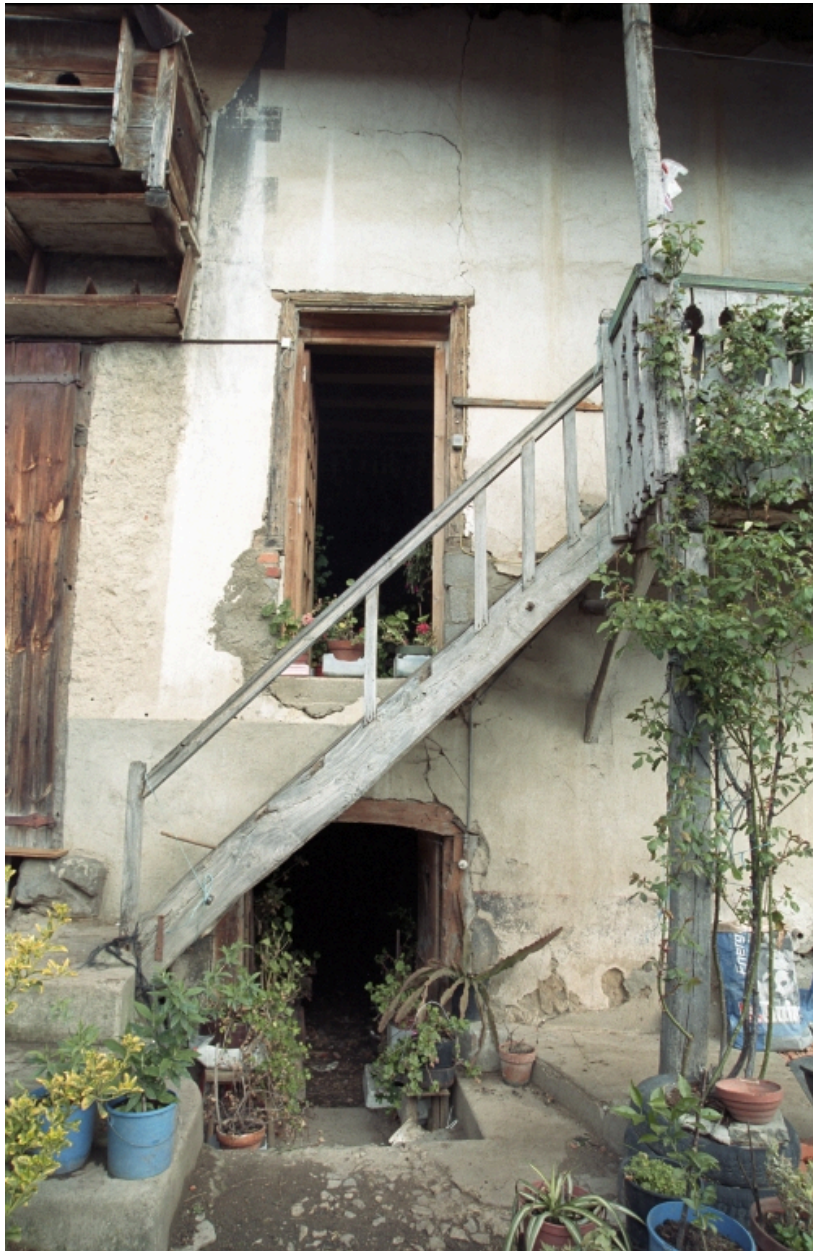
Détail de la partie ouest du logis : cave et étage intermédiaire.
