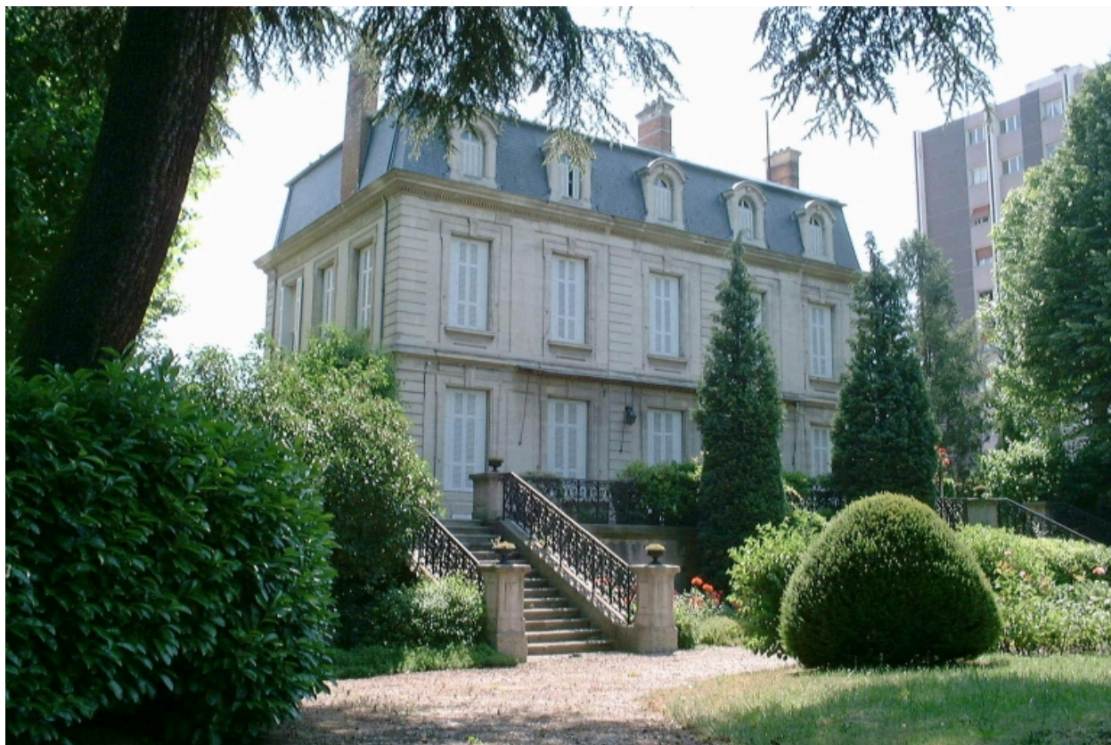
Pavillon d'entrée démoli dans le projet
