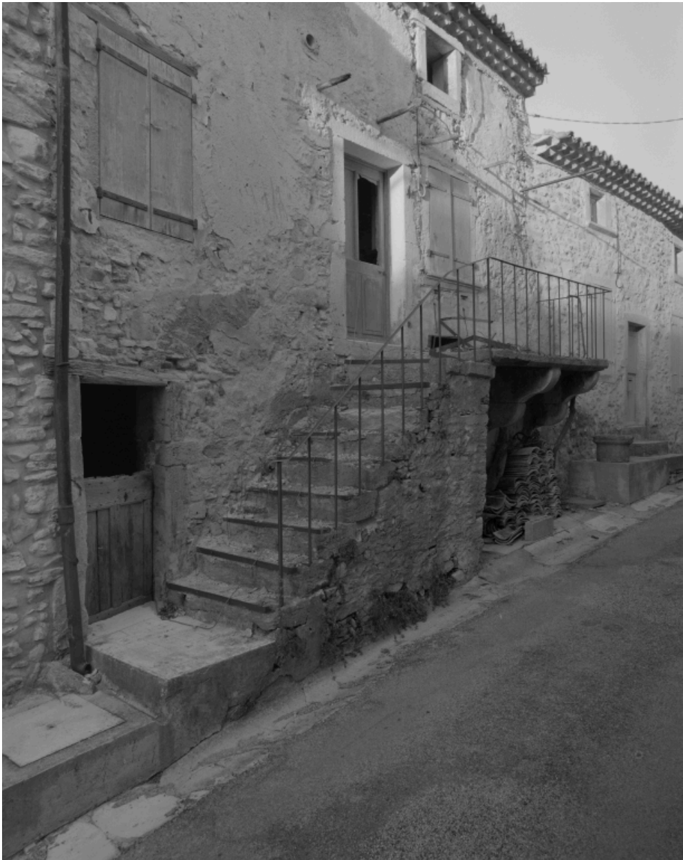
Le Pègue, rue de la Bourgade. Maison (B3 620), élévation principale sur rue.
