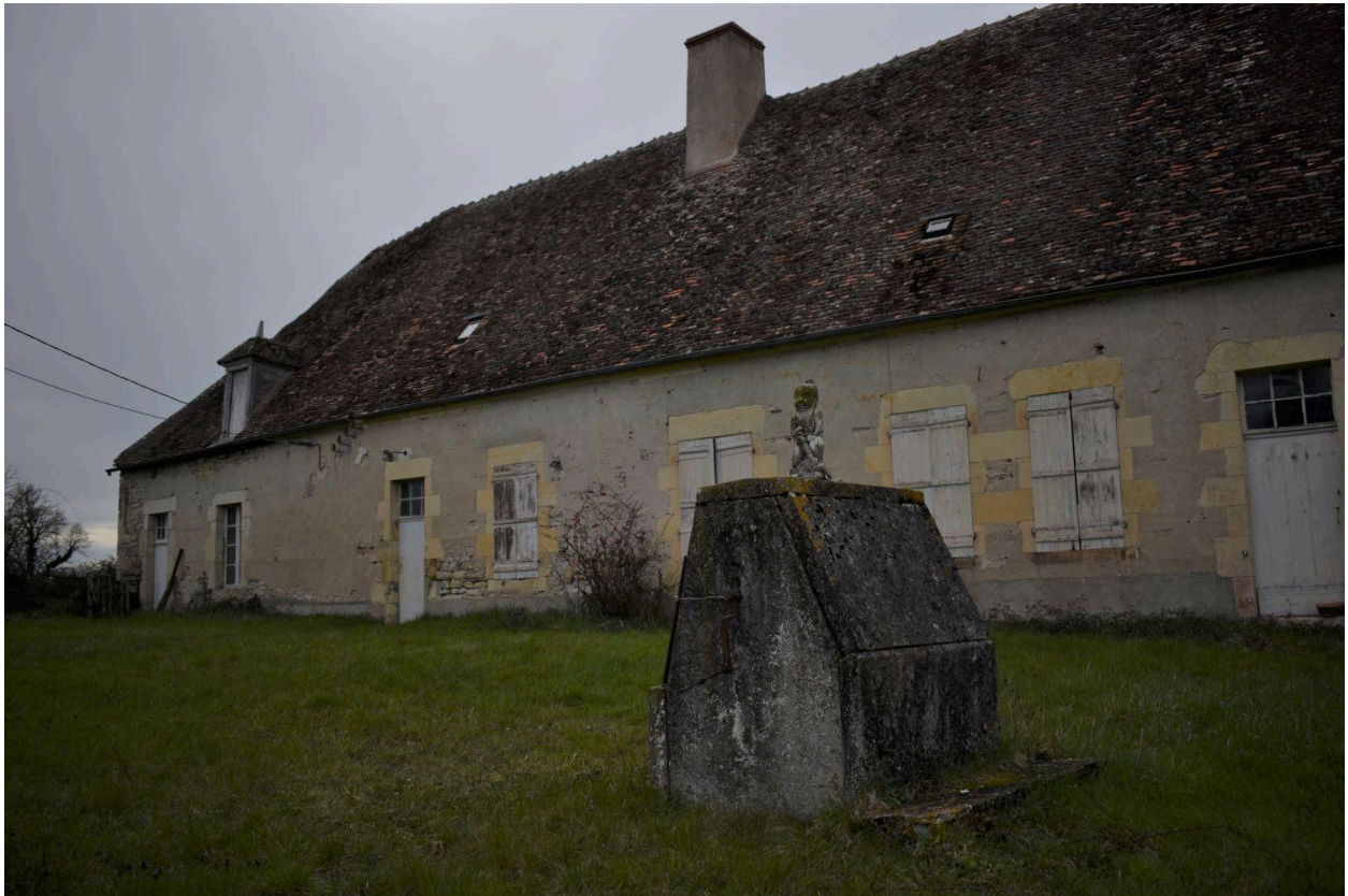
Vue générale de l'ancien logis avec le puits au premier plan.
