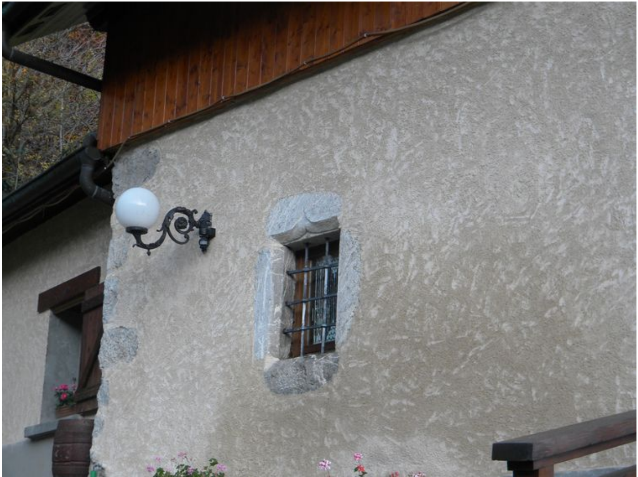
fenêtre à accolade sur la façade d'une ancienne maison (2008 A8 2734);
