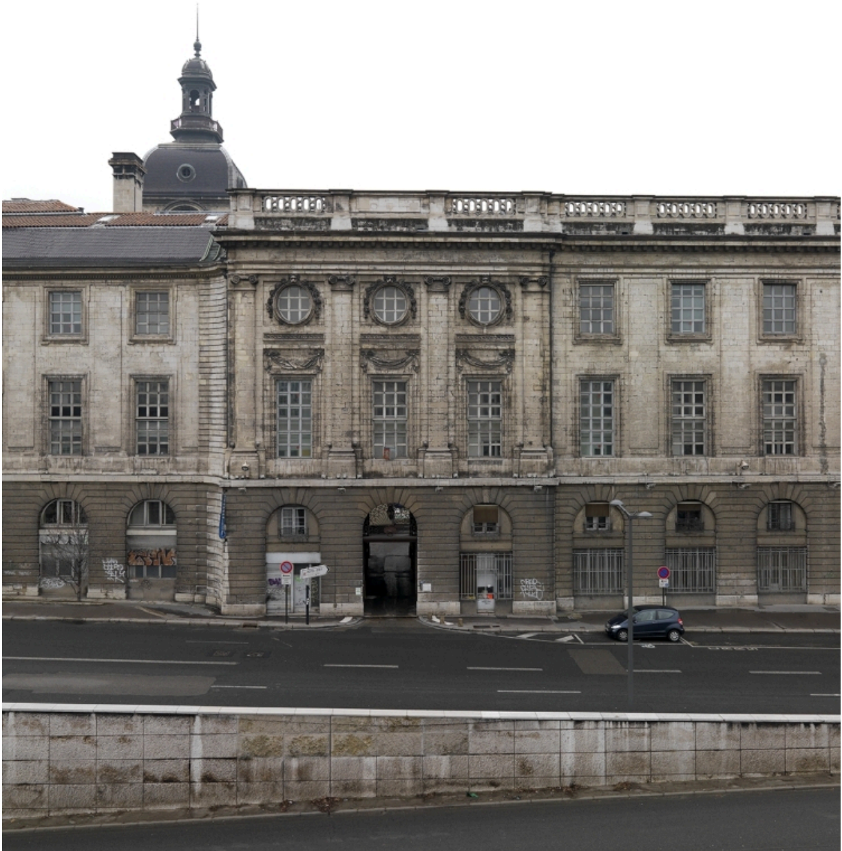
Bâtiment B. L'avant-corps. Vue d'ensemble depuis l'est
