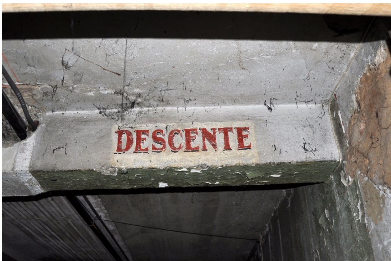
Sous-sol de l'aile N-W : inscription au-dessus de l'ancien escalier
