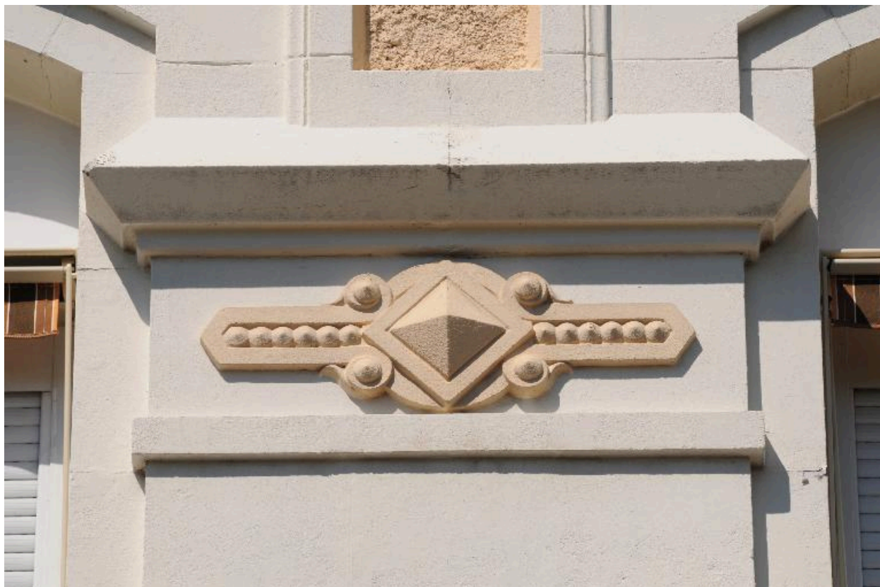
Façade principale, détail du décor
