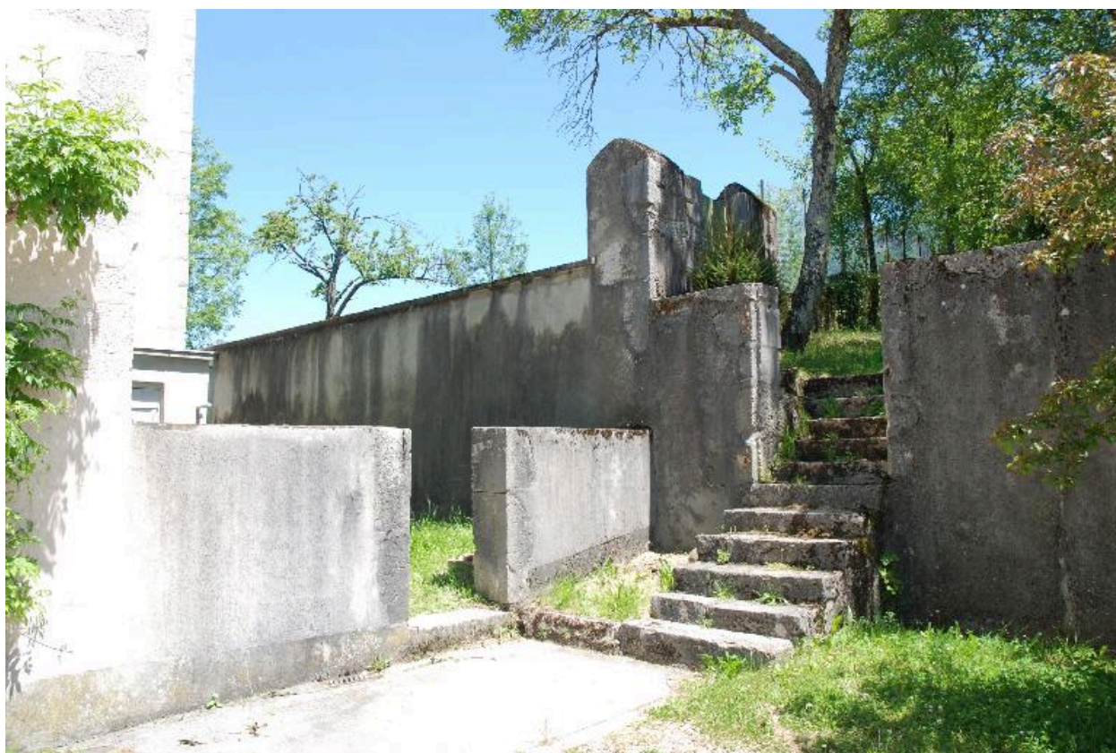
Vue d'ensemble de l'escalier conduisant à l'ancien logis de la ferme du château.
