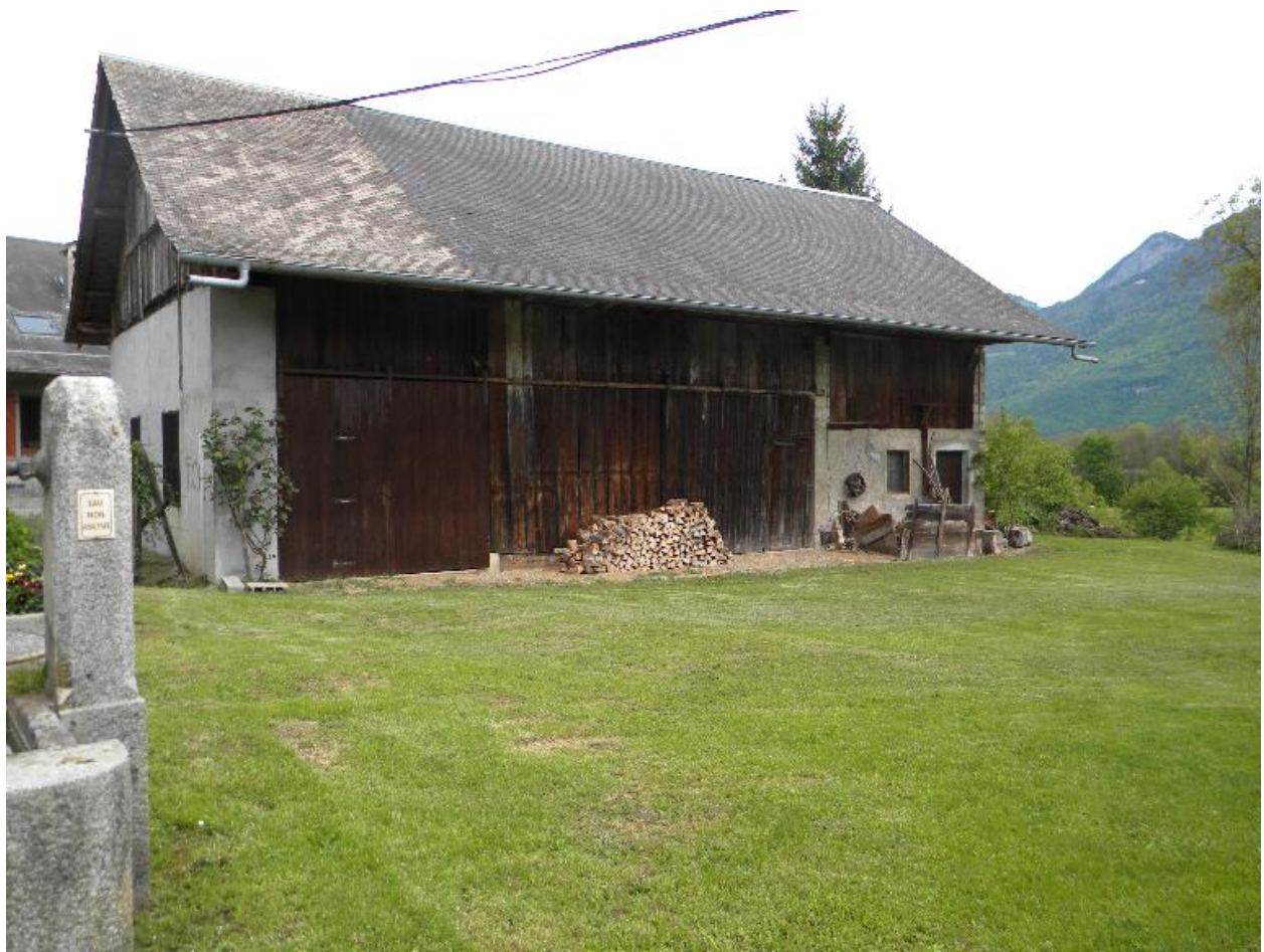
Vue d'une grange-étable (2008 B2 1211).
