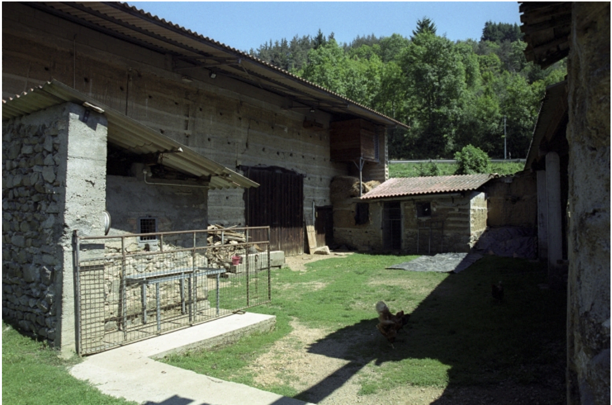
Saint-Laurent-Rochefort, Anzon (1987 A1 2032, 2033), type C1. Vue d'ensemble de la cour et de la grange-étable.
