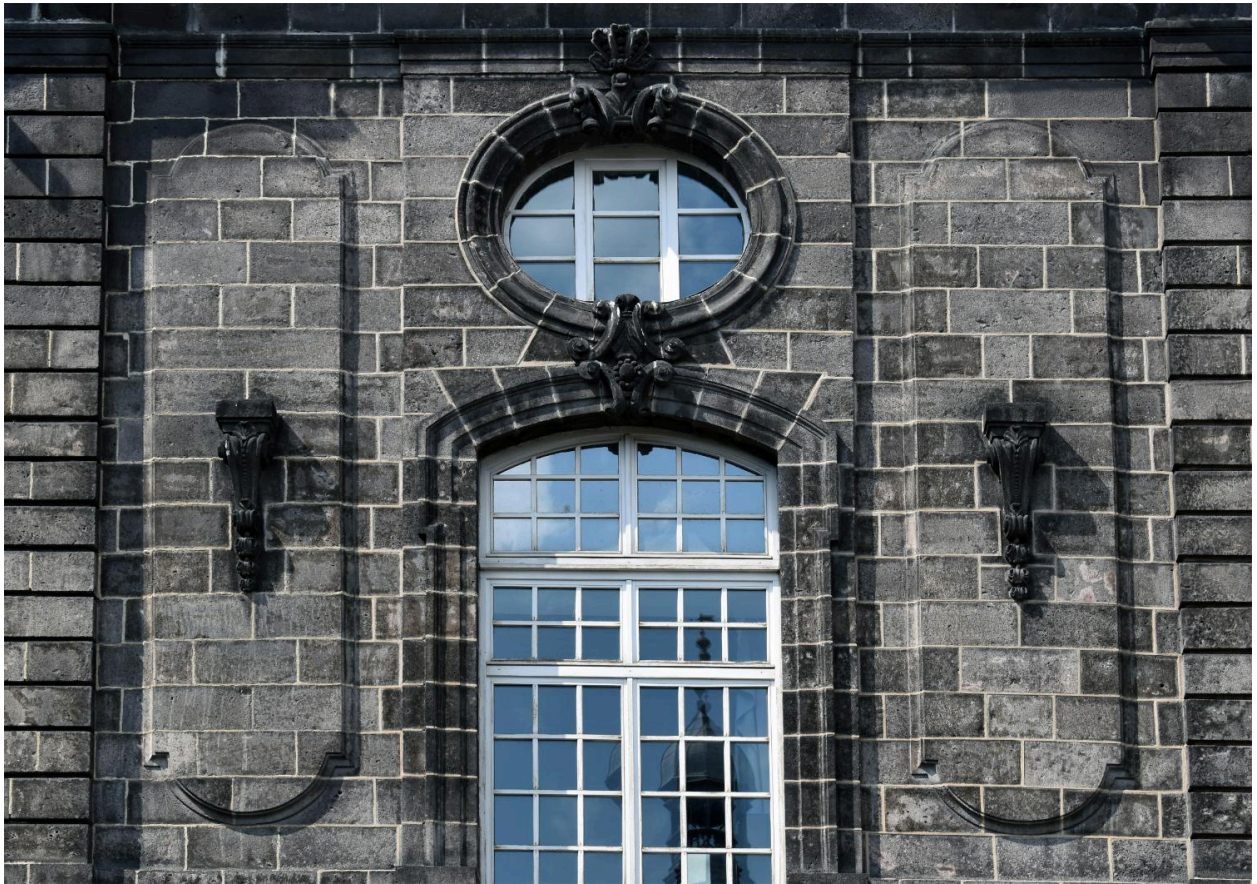
Bâtiment C, élévation principale sur cour : détail du décor sculpté
