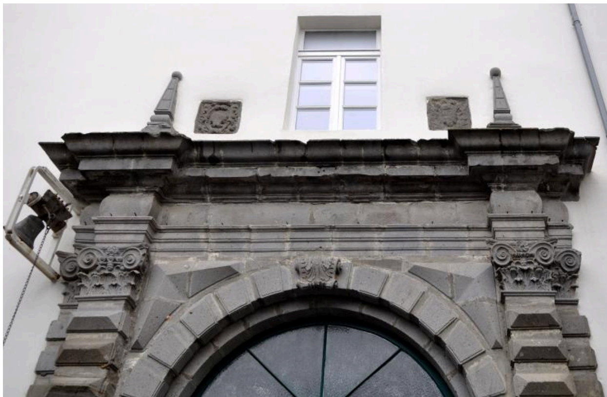
Porte sur cour : détail de la partie supérieure
