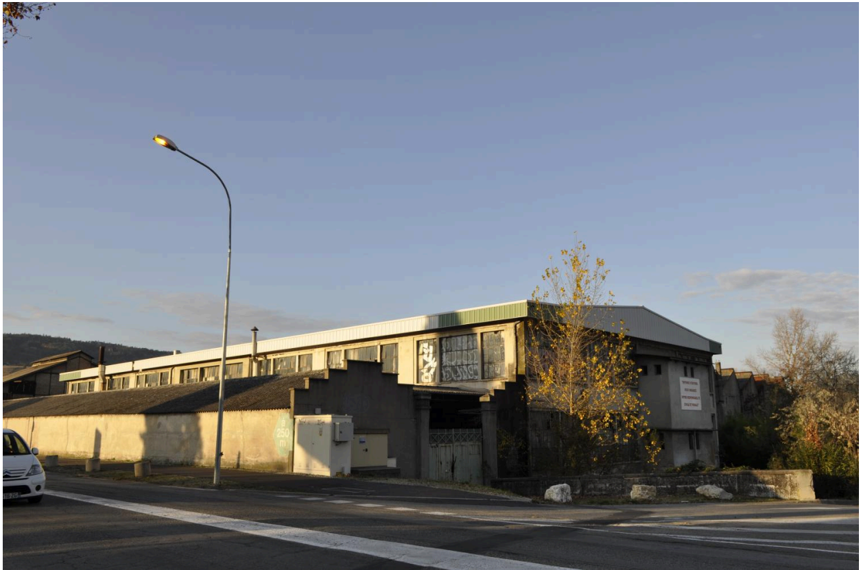
Vue des bâtiments sud
