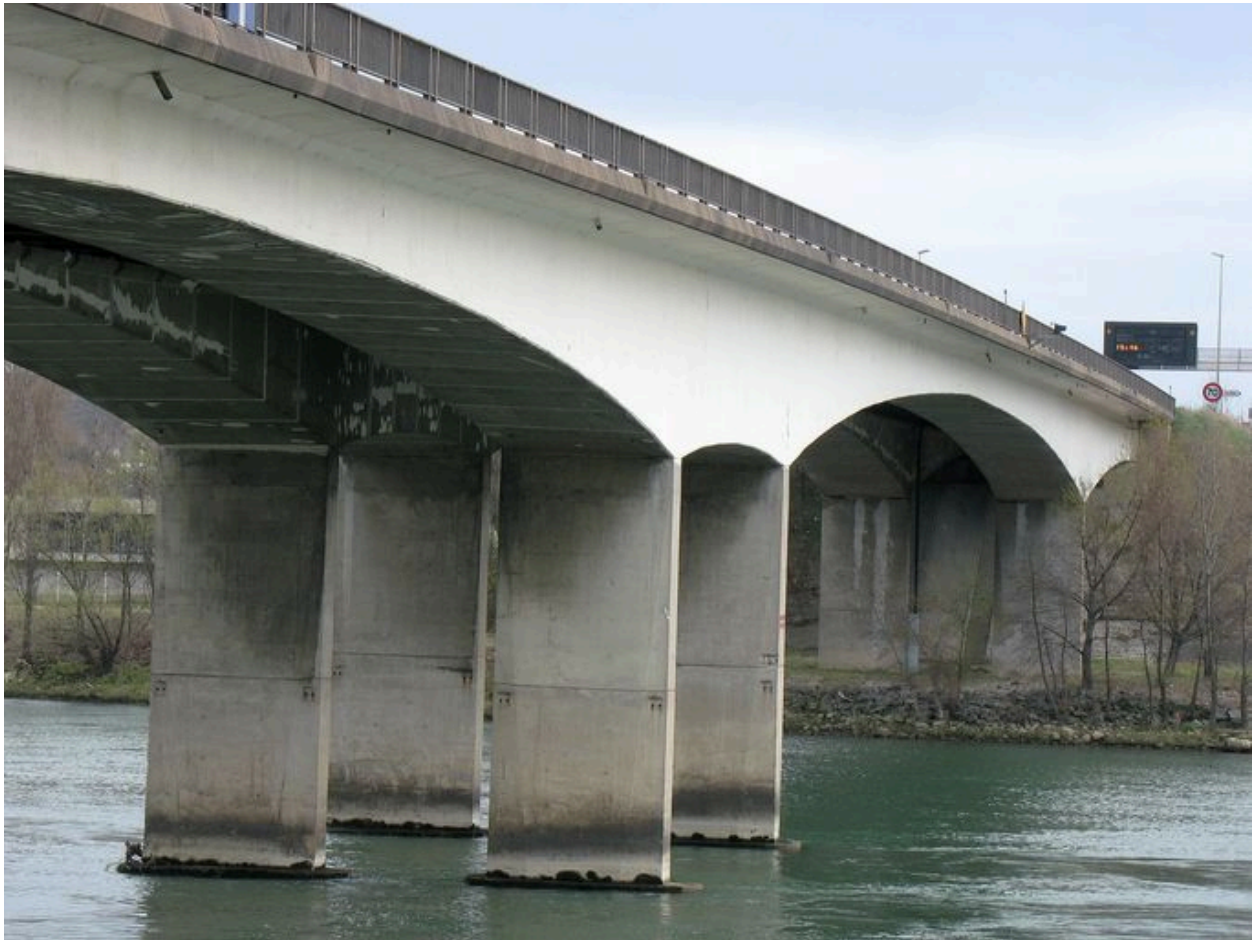
Vue partielle, côté aval, rive gauche
