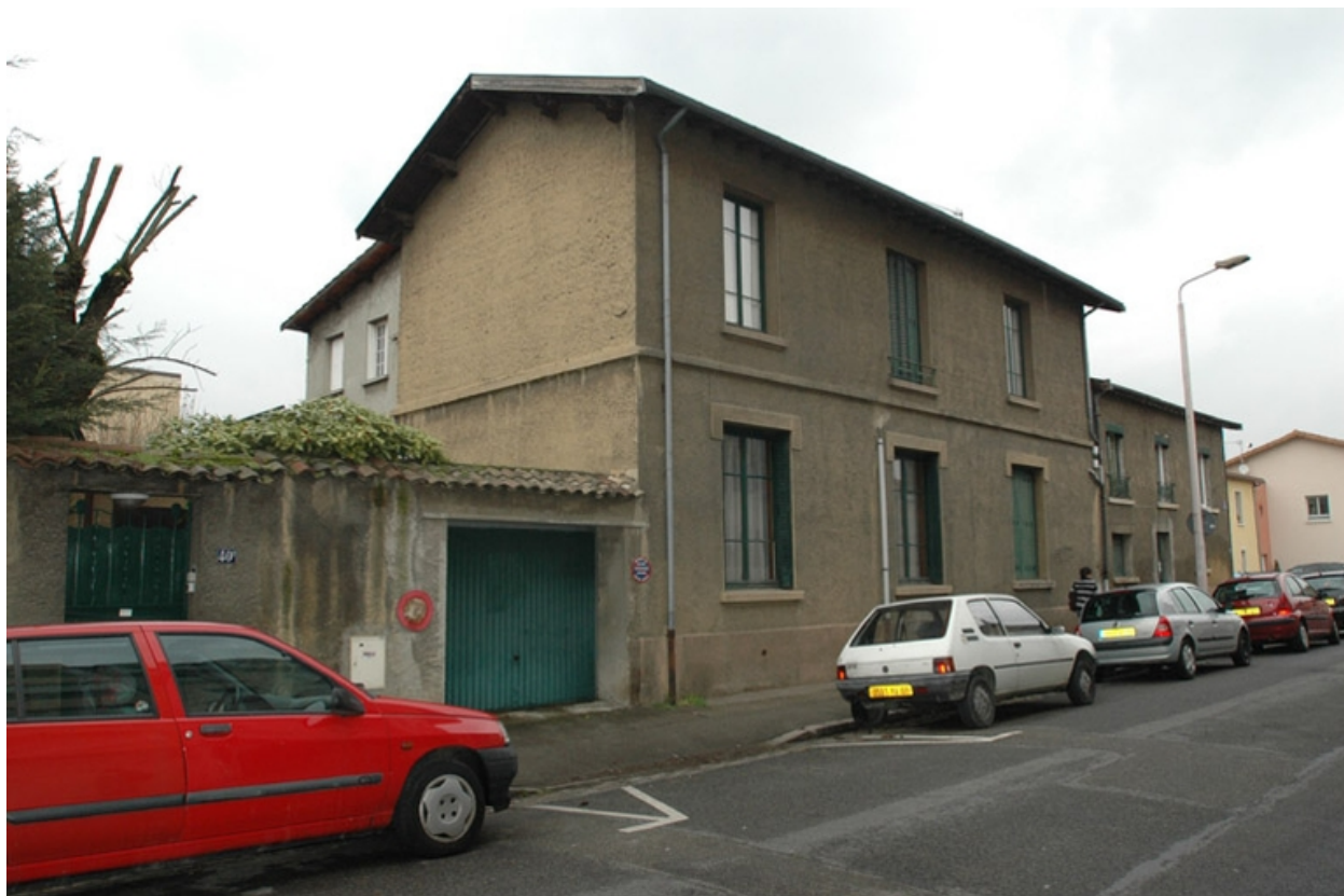
vue extérieure sud : bâtiment de bureaux
